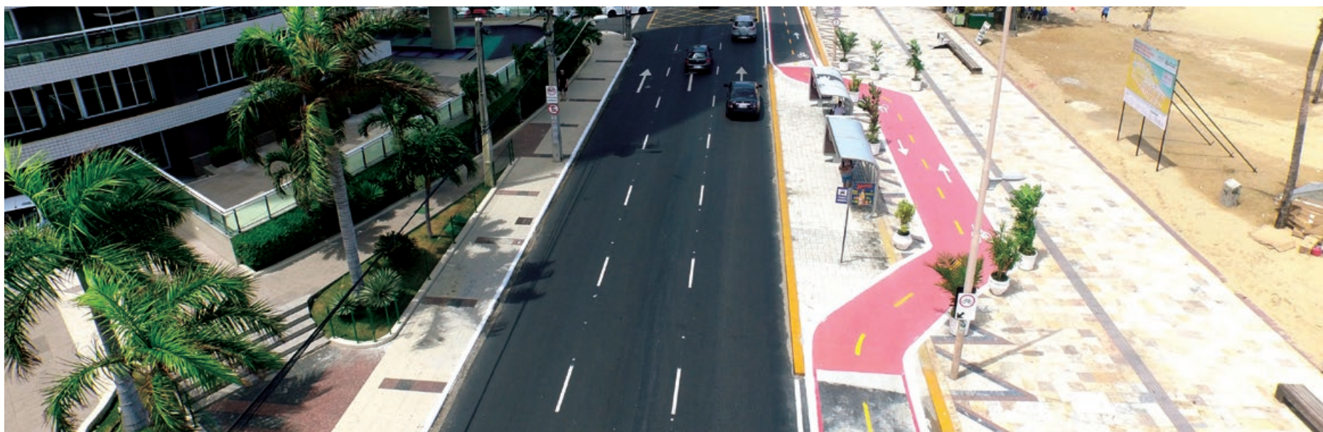
Figura 2.5 | Continuidade da ciclovia junto ao ponto de parada em Fortaleza/CE
