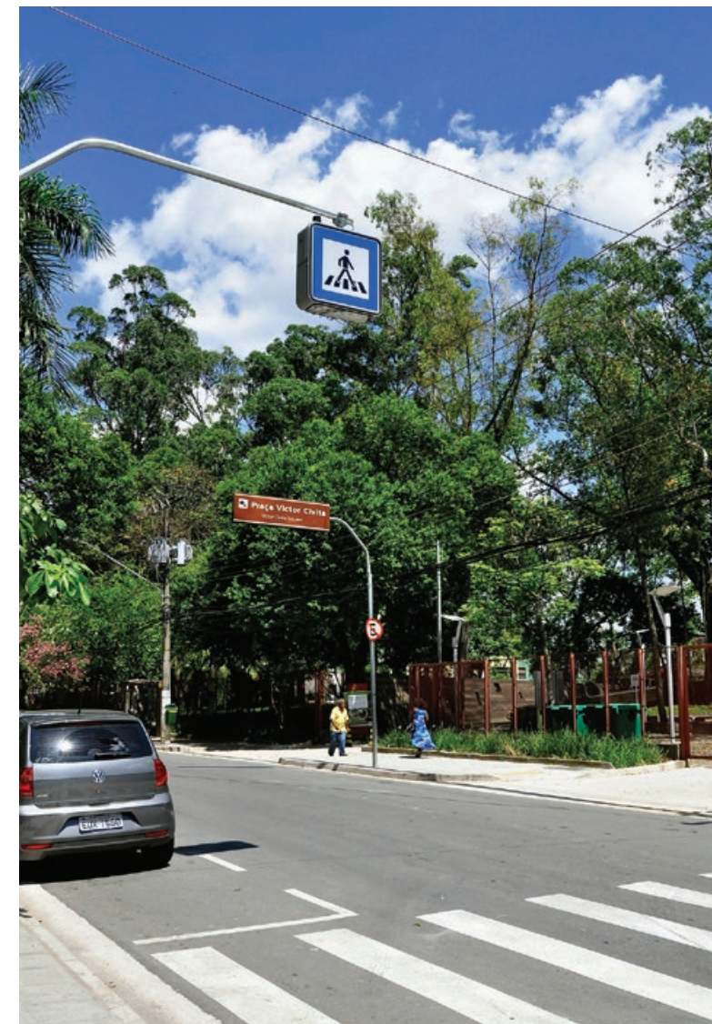
Figura 2.6 | Travessia de pedestres com sinalização específica que possui iluminação interna e um foco de luz direcionado para a faixa de travessia em São Paulo/SP
